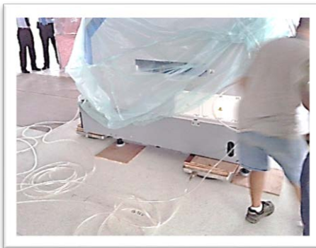
使用安全氣泵為機器定位
